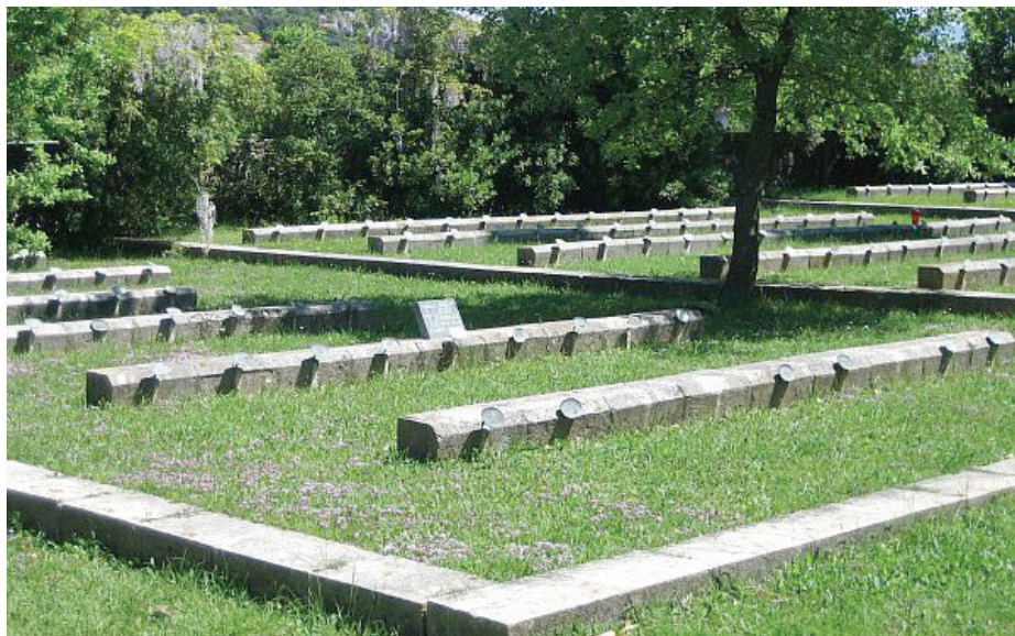
Spominski park Kampor je potreben obnove. Foto: rtslo.si
